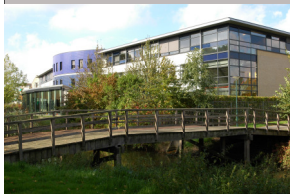
Markland College Zevenbergen (achterzijde gebouw)
